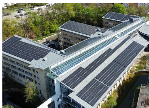
© Solarstromkraftwerk auf dem Landratsamt Bayreuth © Landkreis Bayreuth
