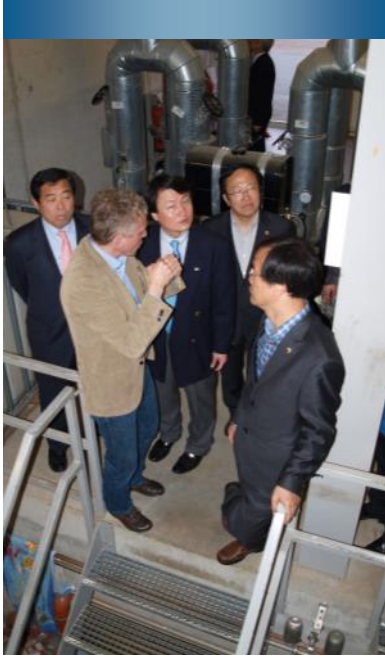
Oben: Besichtigung des Heizkraftwerkes Bayreuth.
