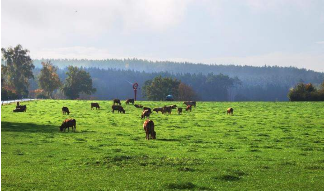
Abbildung 20: „Das Wesentliche ist für das Auge unsichtbar“: Unter der Weide verläuft eine Nahwärmeleitung, die städtische Immobilien mit klimafreundlicher Bioenergie aus der Region versorgt.
