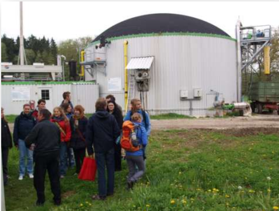
Abbildung 14: Nicht umsonst interessieren sich viele Besuchergruppen für die Biogasanlage der MR Bioenergie Bayreuth auf dem Gelände der Landwirtschaftlichen Lehranstalten in Bayreuth. Ihre Abwärme wird optimal für ein Nahwärmenetz genutzt.
