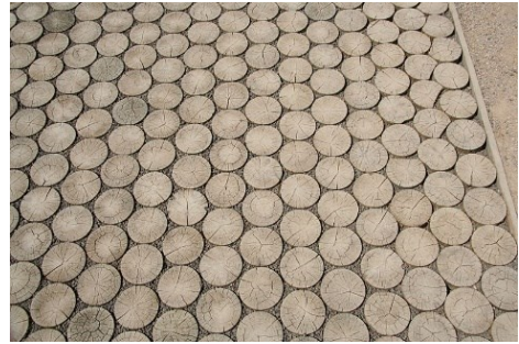
Abbildung 8: Holzpfaster aus Rundholz mit Splittfuge
