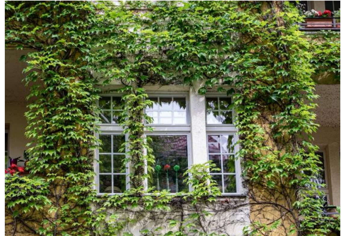
Einfache bodengebundene Fassadenbegrünung
