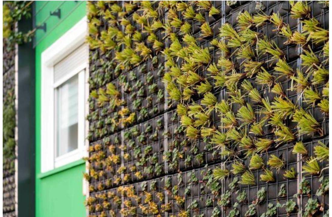
Vorgefertigte Grünmodul kurz nach Einbau
