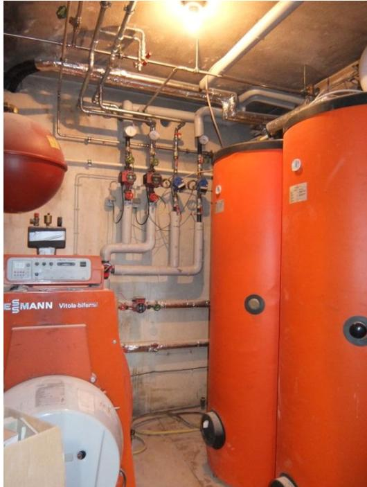
Zur Warmwasserbereitung stehen zwei 470 Liter Solar-Speicher zur Verfügung.
