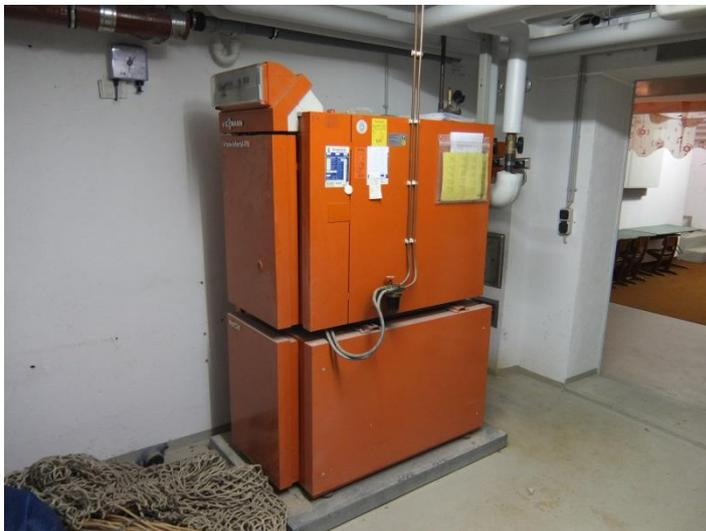
**Abb. 11: Kindergarten, Wärmeerzeugung/Heizölkessel mit unten liegendem Warmwasserspeicher: 160 Liter**
