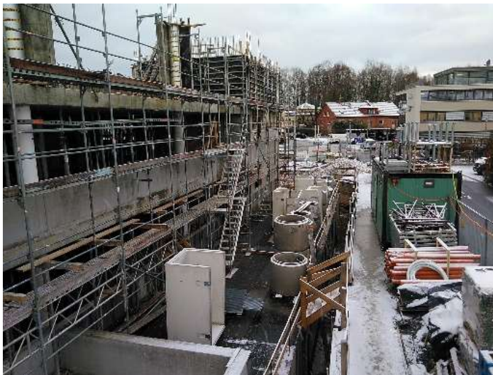
Januar 2019: - Stand Rohbau im 2. Obergeschoss
