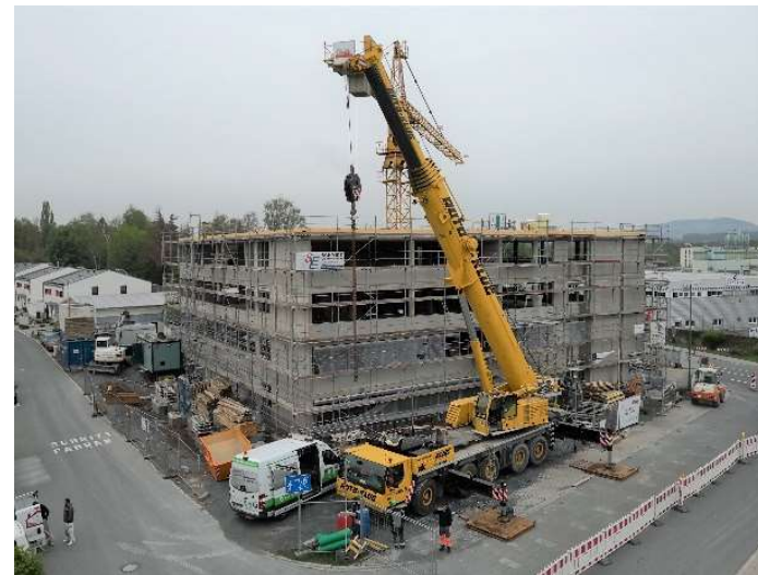
April 2019: - Rohbau abgeschlossen - Abbau Hochbaukran
