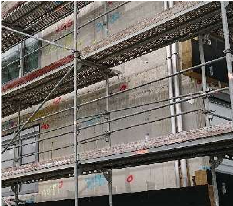
Aufmaß der Fassade für die Produktion der PV-Paneele. Systemschnitt
