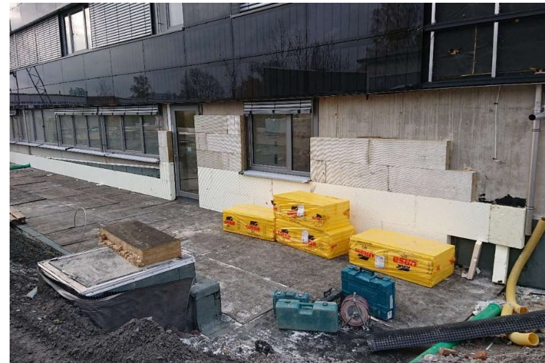
Okt./Nov. 2019: voranschreitende Arbeiten an der Rückseite, WDVS EG
