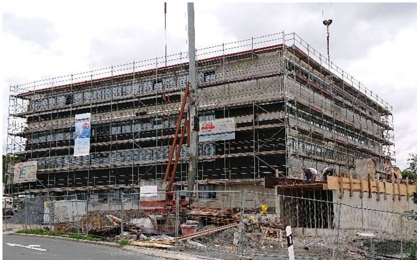
Sep./Okt. 2019: voranschreitende Arbeiten an der Nürnberger Straße
