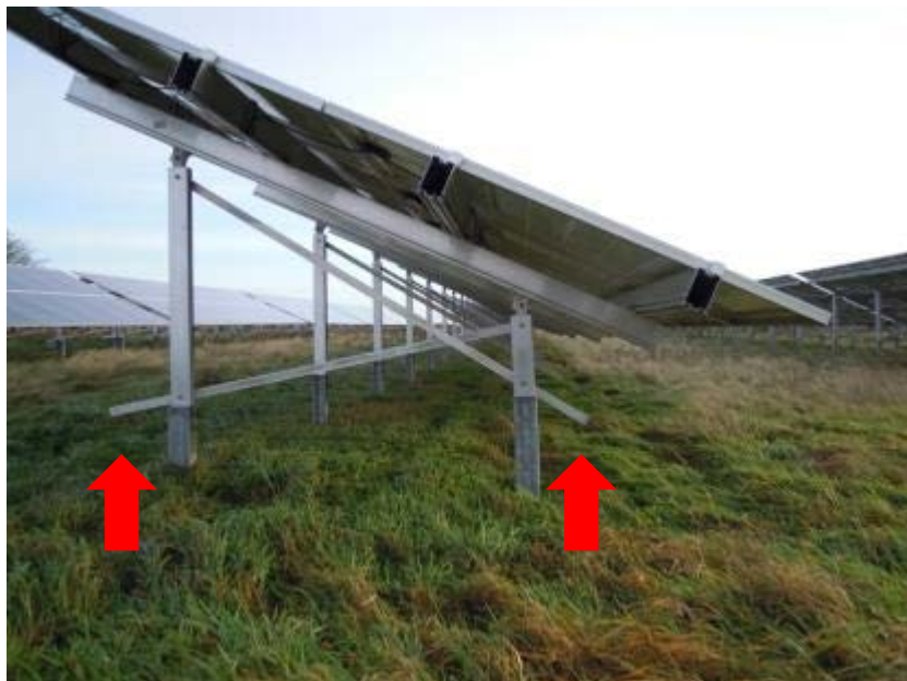
Abbildung 12: Vorstehende Flacheisen können Mensch, Hund und Schaf verletzen (Foto: M. Gertenbach, LWK Niedersachsen).
