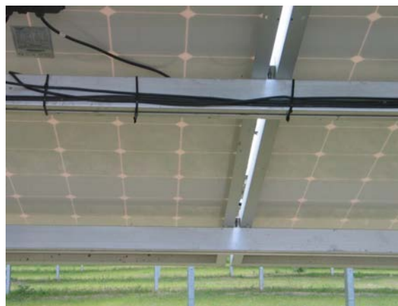
Abbildung 16: Kabelbinder halten die Kabel am Modul (Foto: M. Jurkschat).
