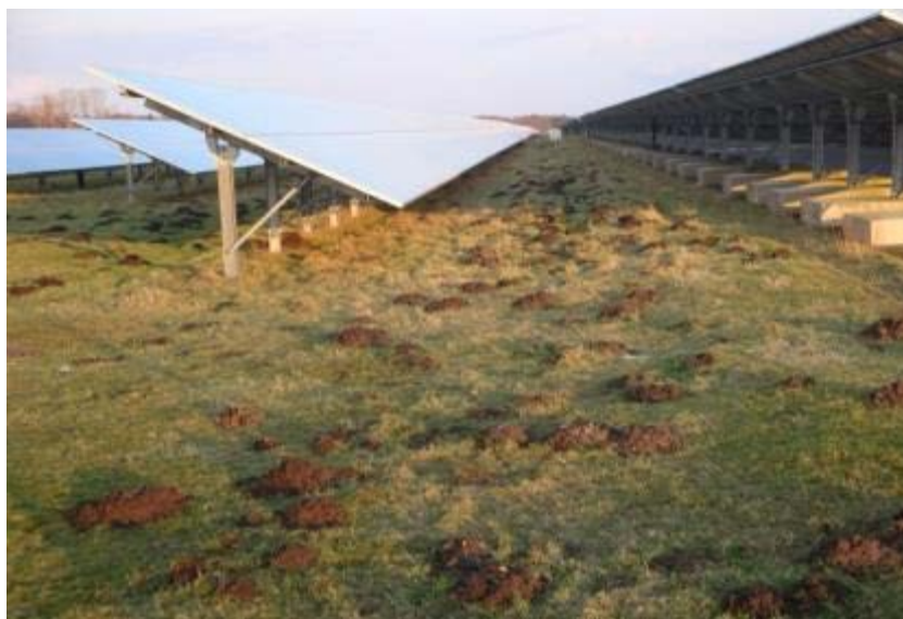
Abbildung 3: Auf Grund der Maulwurfshügel könnte diese Fläche nicht gemäht werden. Eine Schafbeweidung ist hier problemlos möglich und tritt zudem die entstandenen Löcher und Gänge zu (Foto: K. Gerdes, Solarpark Fliegerhorst Oldenburg).
