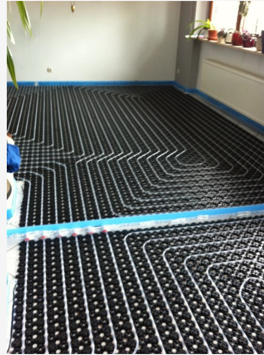
Verlegen der Systemplatten und der Fußbodenheizungsrohre sowie Dehnungsfugen
