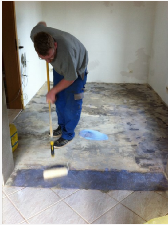
Vorbehandlung des ursprünglichen Fußbodens mit Haftgrund
