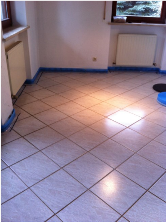
Verlegen der Randdämmstreifen
