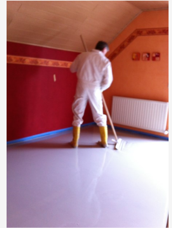
Einbringen des Carbonestrichs
