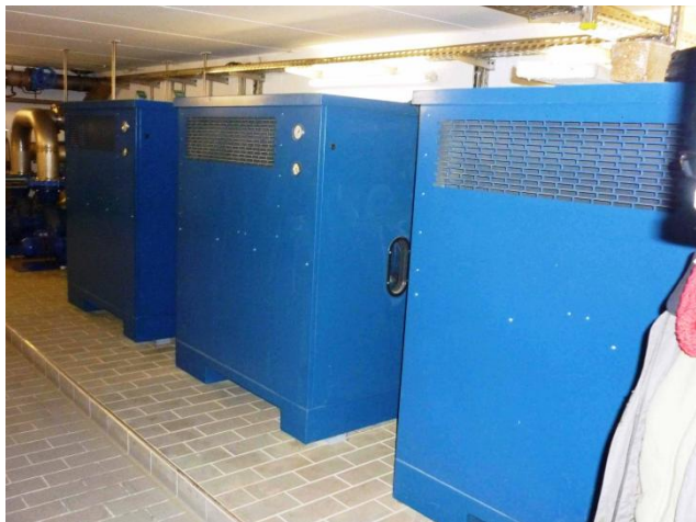
Abb. 8: Gebläsestation mit drei Drehkolbengebläsen
