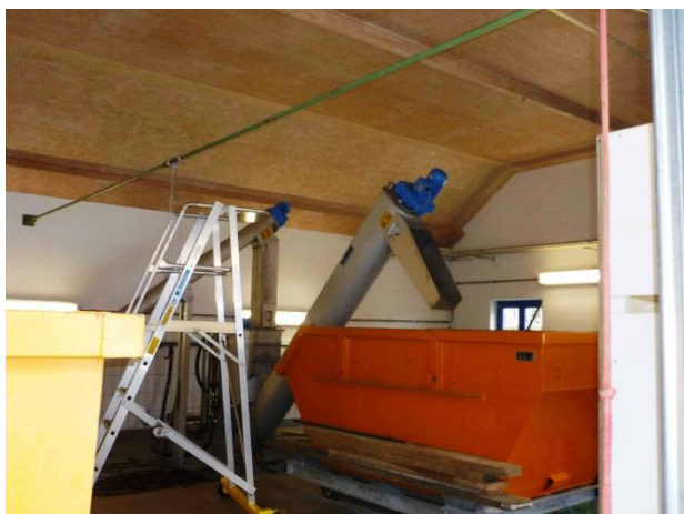
Abb. 5: Sandfang mit Container
