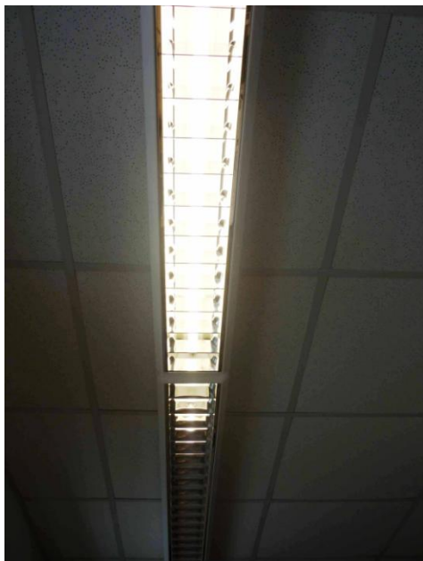
Abb. 24: Beleuchtung: Rasteranbauleuchte
