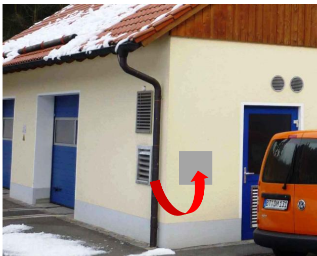
Abb. 31: Handlungsempfehlung: Verlegen Fortluftöffnung
