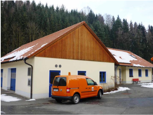
Abb. 11: Rechengebäude (links) mit dahinter liegendem Betriebsgebäude
