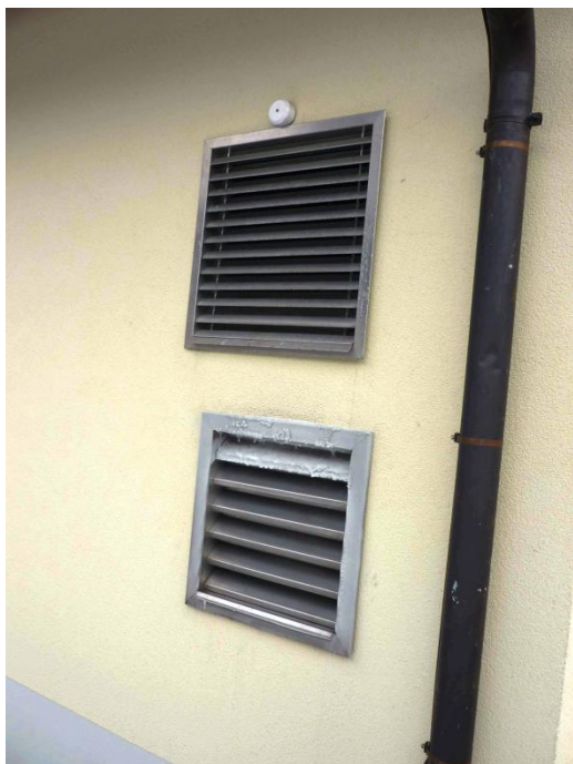
Abb. 29: Ansaug- und Ausblasöffnungen
