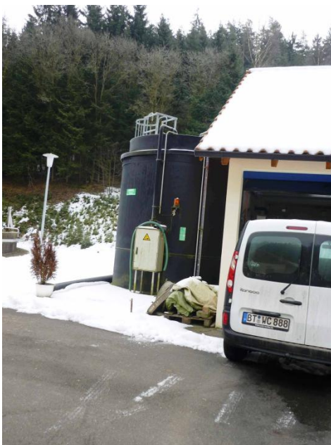
Abb. 13: Fällmittelanlage
