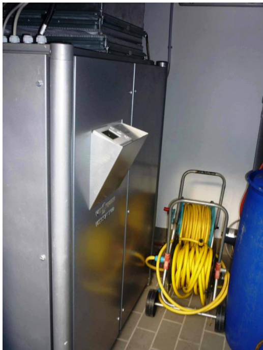
Abb. 28: Luft-Wärmepumpe
