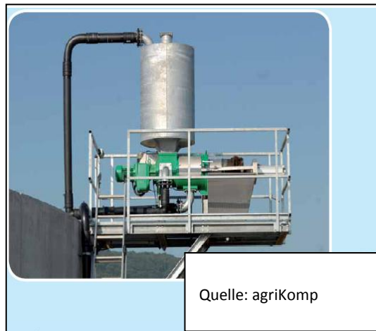
Übersicht 3: links: Abscheidegrad eines Pressschneckenseparators bei der Separierung von Rindergülle (nach Boxberger et al. 1992); rechts: montierter Separator an einem Gärrestbehälter
