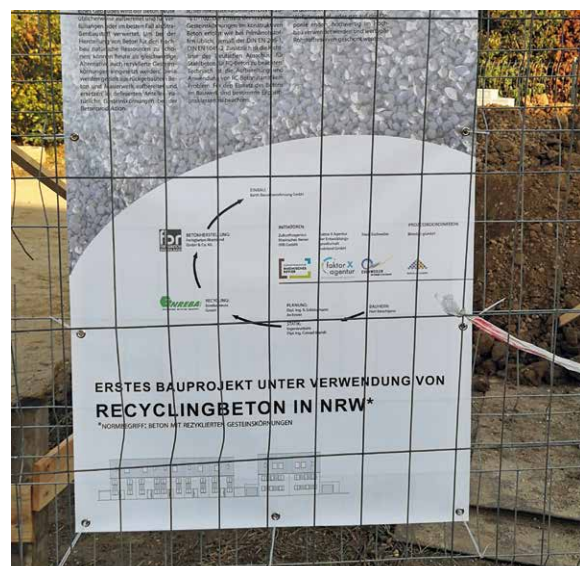
Erstes Recyclingbeton-Projekt in NRW
