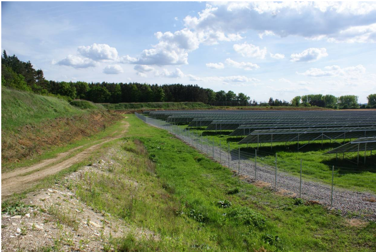
Abb. 64 :Solaranlage Engelbrechtsmünster liegt in einer teilverfüllten Kiesgrube © Barbara Grundner-Köppel, Landschaftsarchitektin Mühldorf a. Inn
