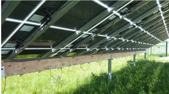
Abb. 22: Unterkonstruktion aus Stahlprofilen und Holz- trägern
