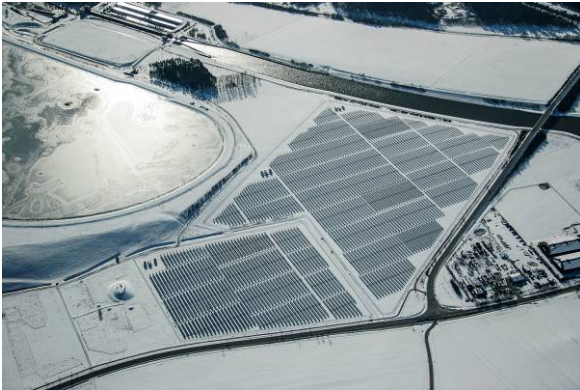
Abb. 43: Im Luftbild lässt sich die Anlagenstruktur gut erkennen; links unten im Bild der Aussichtshügel © Klaus Leidorf
