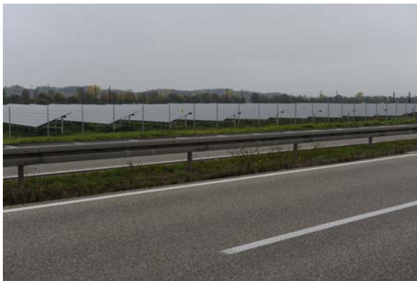
Abb. 2: „Landschaftsbildprägend“: Photovoltaik-Anlage ohne Einbindung entlang einer Straße © J. Ermisch
