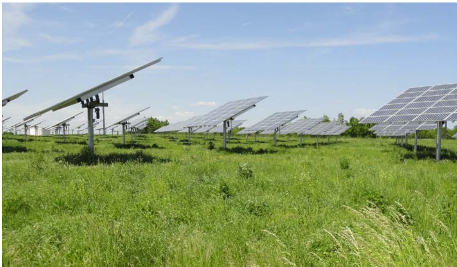
Abb. 25: Moveranlagen; Grün- dung mit gerammten Stahlrohren
