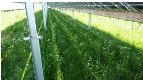
Abb. 21: Verankerung mit gerammten Profilen
