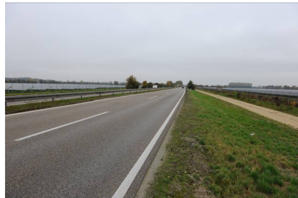
Abb. 3: Vorbelastung: Photovoltaikanlagen beidseits entlang der Straße in langegezogenen Streifen © J. Ermisch
