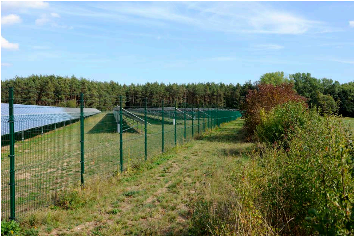
Abb. 55: Photovoltaik Albersreuth: Einbindung durch umgebenden Wald sowie ergänzende Hecke © J. Ermisch
